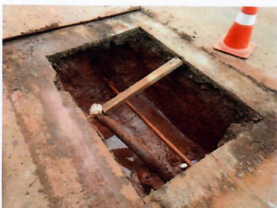
Foto 09. Detalhe das valas abertas para a execução dos serviços.
