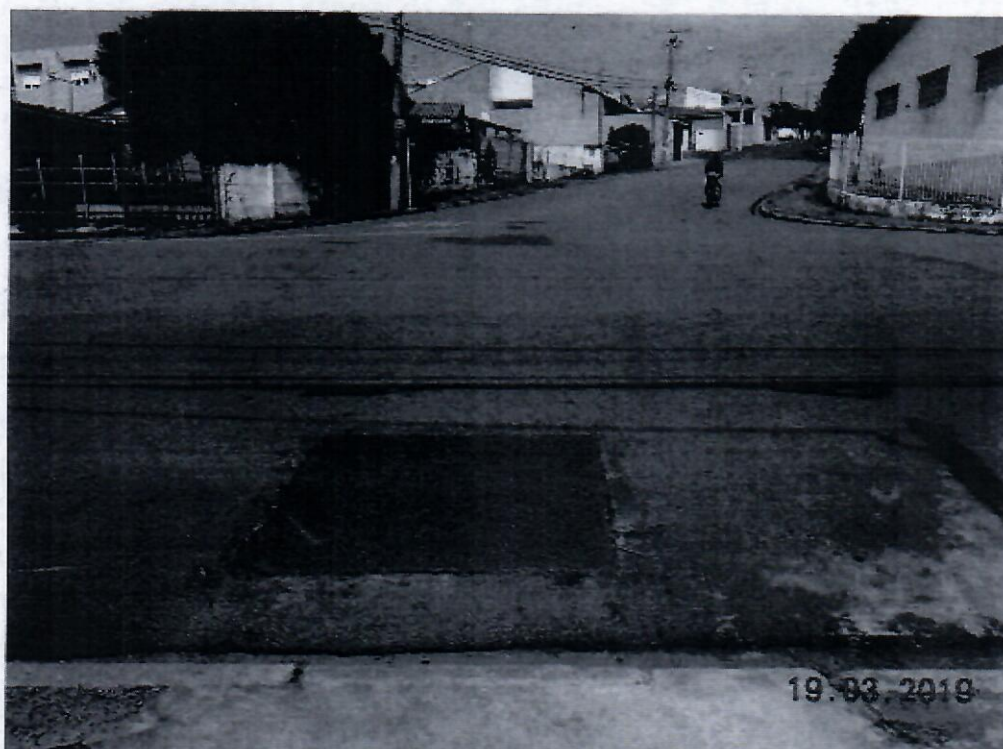
Foto 2 – Recapeamento pós implantação da adutora DN 100mm pelo MND no Poço Leopoldina
