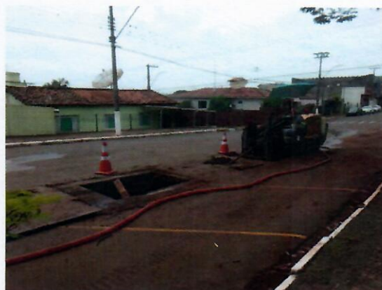
Foto 06. Equipamento que executa a tubulação pelo método não destrutivo.
