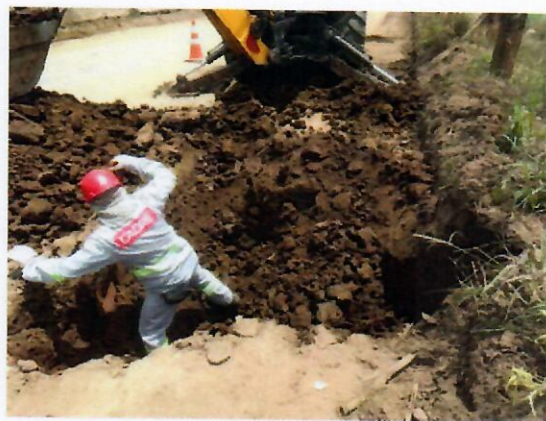
Foto 12. Funcionário realizando a sondagem da tubulação.
