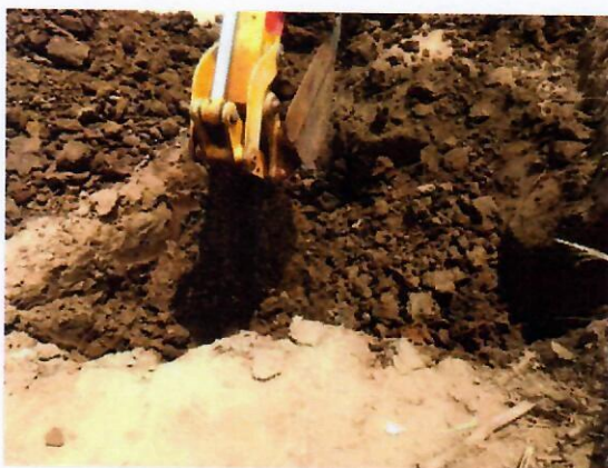
Foto 11. Detalhe da máquina abrindo a vala para encontrar a tubulação de recalque do Poço Leopoldina para executar a interligação.
