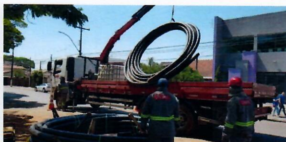
Foto 04. Tubulação de PEAD de 100 mm a ser instalada.
