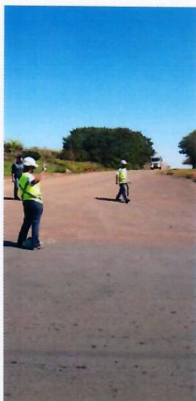
Foto 01. Equipe realizando sondagem de interferências no caminhamento da adutora.
