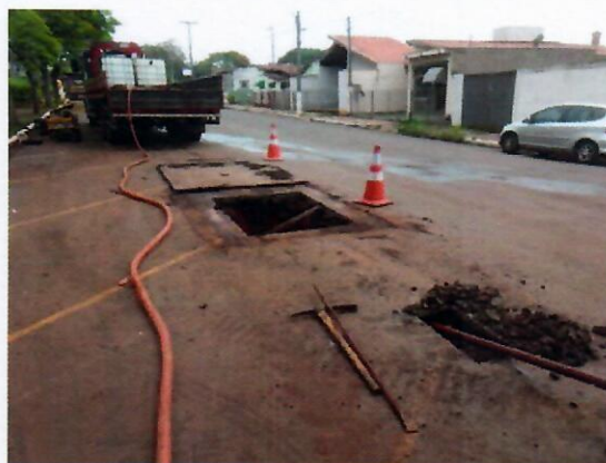
Foto 08. Detalhe das valas abertas para a execução dos serviços.
