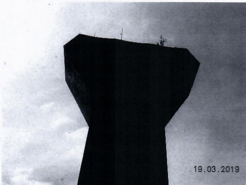
Foto 13 – Antena do sistema de telemetria do Reservatório Central
