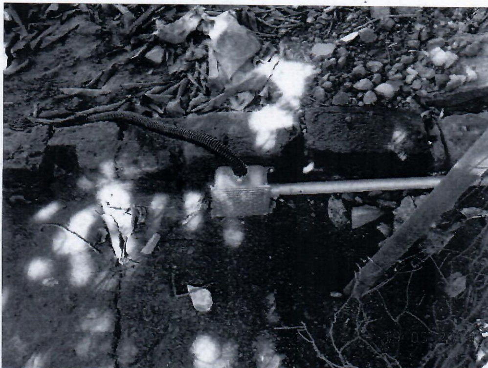
Foto 7 – Caixa e conduites do sensor de nível instalado no Reservatório S. Carlos
