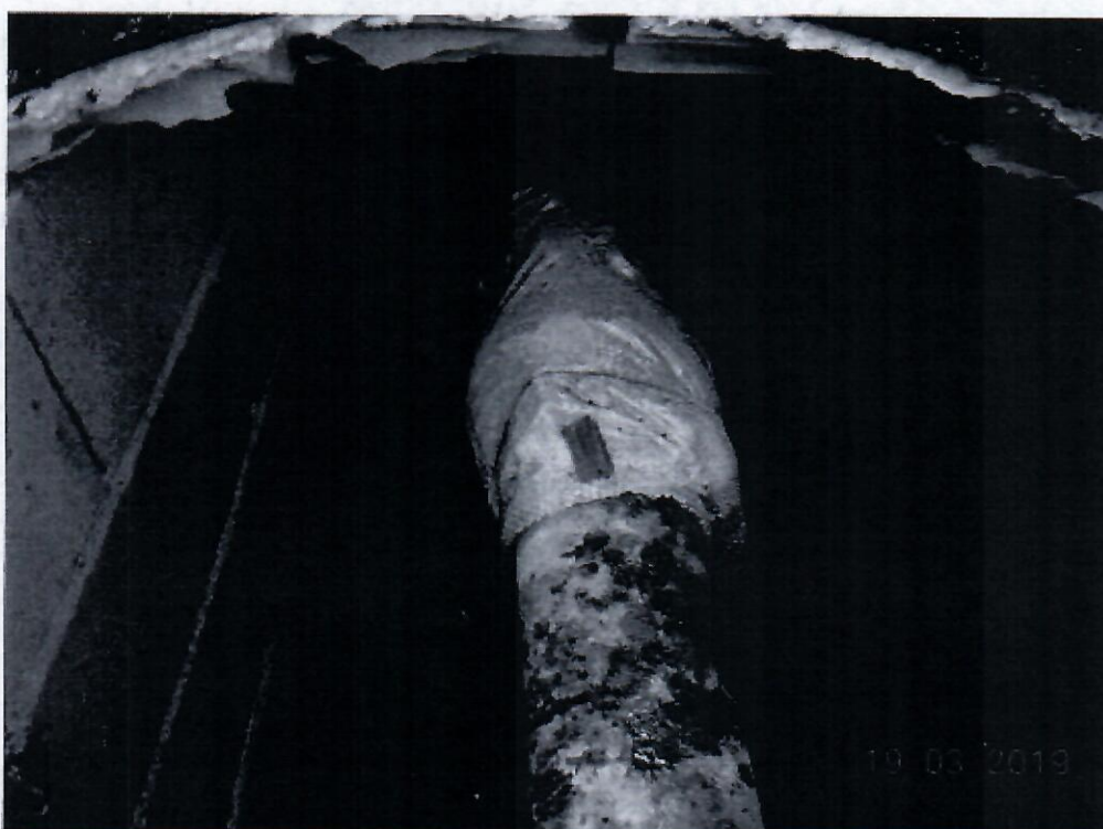
Foto 14 – Macromedidor de vazão instalado em tubulação do Reservatório Caixa Mãe
