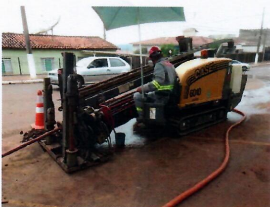
Foto 07. Equipamento que executa a tubulação pelo método não destrutivo.
