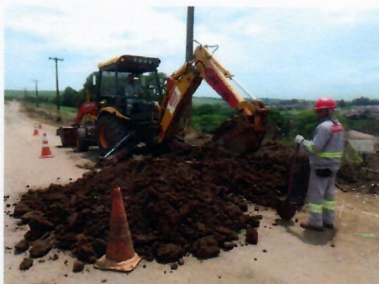
Foto 10. Máquina abrindo a vala para encontrar a tubulação de recalque do Poço Leopoldina para executar a interligação.
