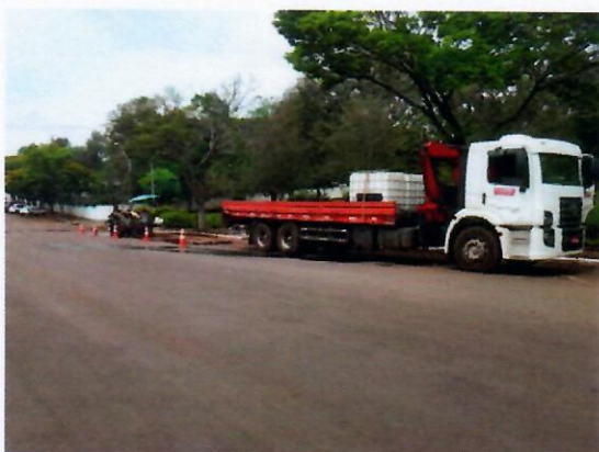
Foto 05. Caminhão tipo “Munck” de apoio.
