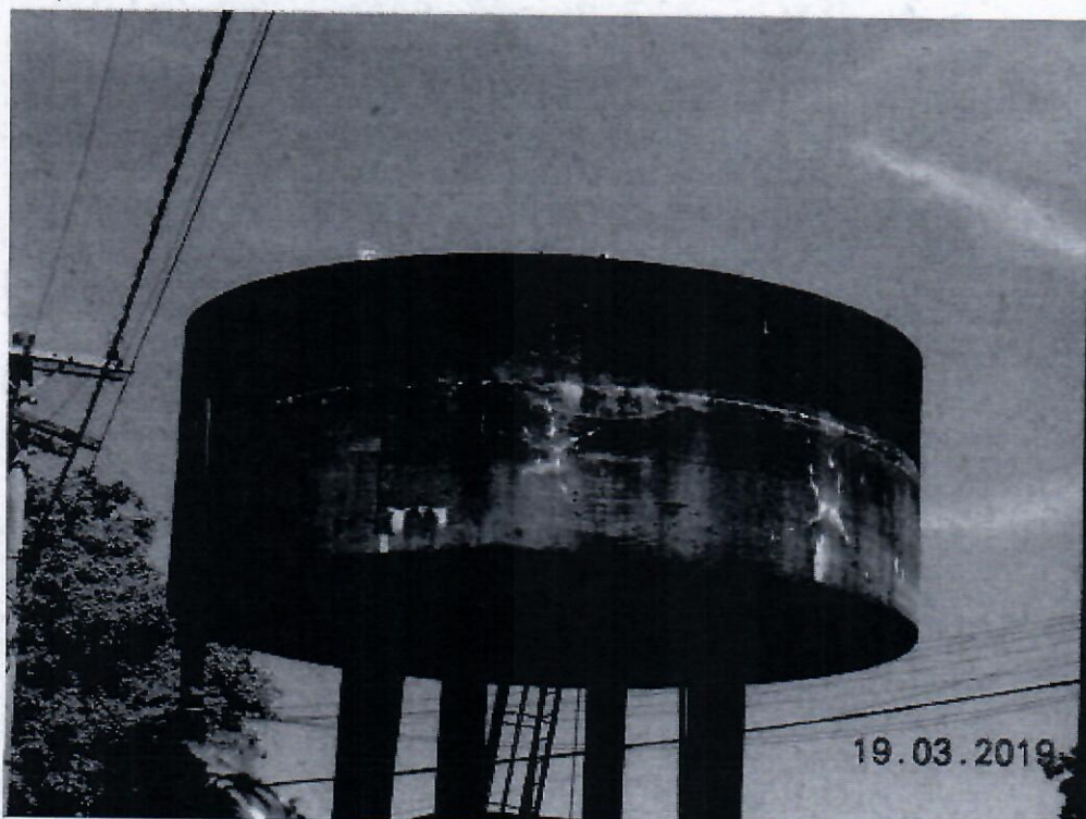
Foto 24 - Antena do sistema de telemetria do Reservatório do Distrito Industrial
