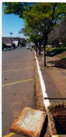
Foto 02. Equipe realizando sondagem de interferências no caminhamento da adutora.
