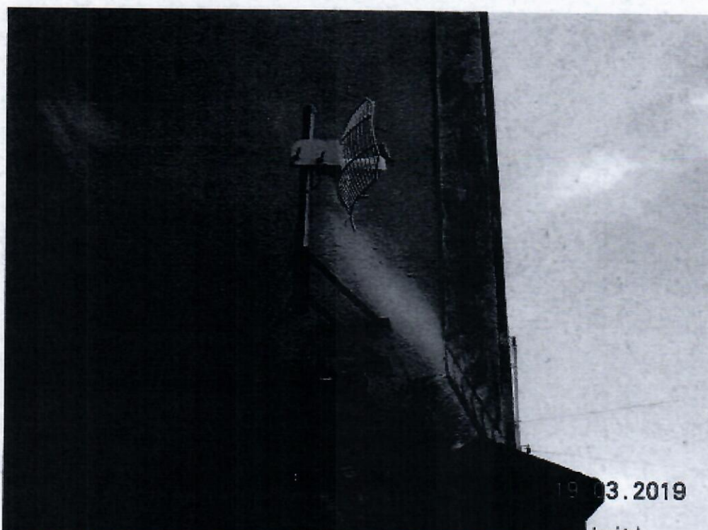
Foto 16 – Antena do sistema de telemetria do Reservatório Caixa do Mãe
