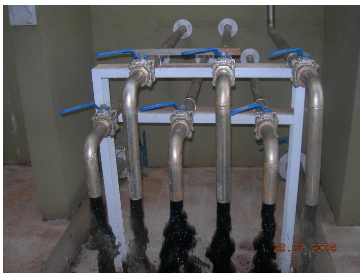
Foto 4: Amostradores do lodo: pontos 1 a 5 da esquerda para a direita correspondem ao lodo anaeróbio; o amostrador da direita corresponde ao lodo aeróbio.
